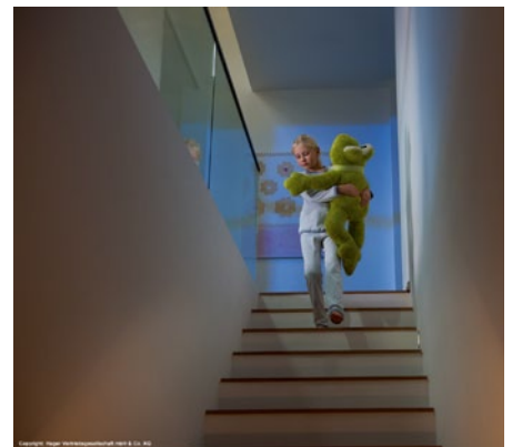
Dank eines Bewegungsmelders werden Durchgangsbereiche wie Treppe und Flur automatisch beleuchtet und dadurch viel sicherer. (Foto: Hager Vertriebsgesellschaft)
