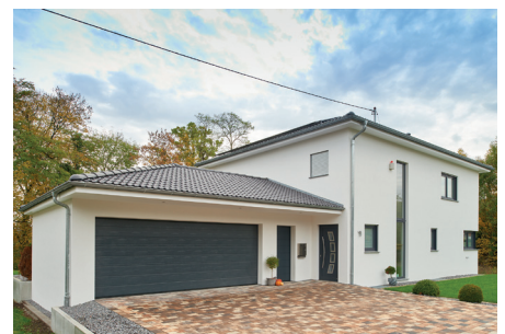
Smarte vier Wände: Dank der Haussteuerung domovea von Hager wurde der Traum der Familie Hemmer von einem intelligenten Zuhause wahr. (Foto: Hager Vertriebsgesellschaft)
